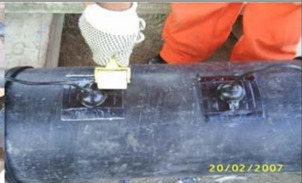
Foto 10: Instalación de Handy Cap
