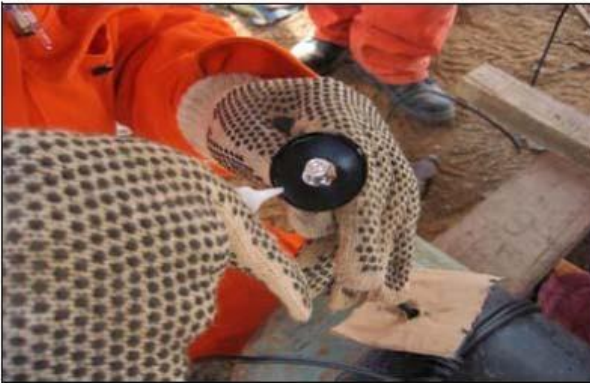
Foto 7: Aplicación de pegante AC 10. Kit Protabond.
