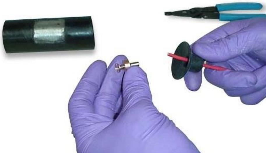
**Paso 3: con una pinza crimpadora ajustar el cable al conector.**
